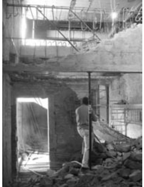
Der Stadtumbau am Alten Theater geht voran! Am 15.09.2007 gibt es mehr zu sehen.
